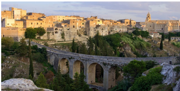
Figure: Ponte acquedotto intitolato alla Madonna della Stella, Gravina di Puglia (1743).
